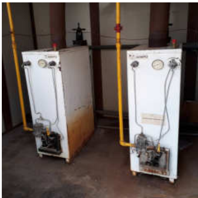
Видимое изображение №3 Трубопроводы обвязки котлоагрегатов
