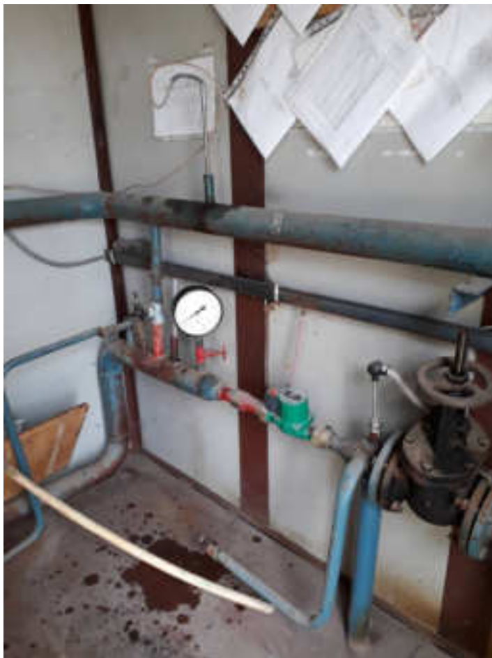
Видимое изображение №3 Трубопроводы обвязки котлоагрегатов
