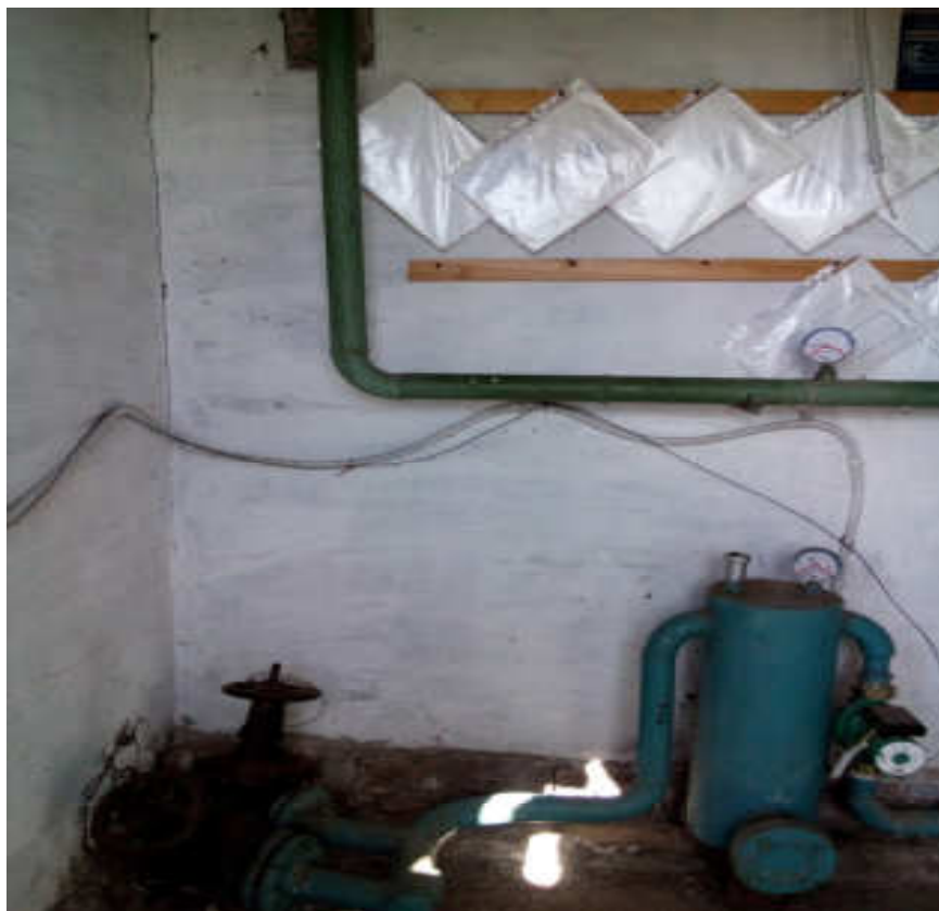
Видимое изображение №2 Обвязка насоса
